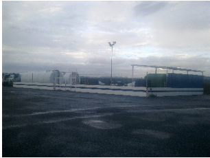
Instalaciones portuarias para el almacenamiento temporal de residuos, con bombas de gran potencia, skimmers, tanques, cubetos, ...
