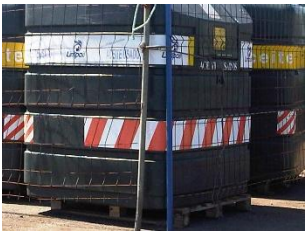
Contenedores para el almacenamiento en instalaciones portuarias de aceites usados y residuos oleosos
